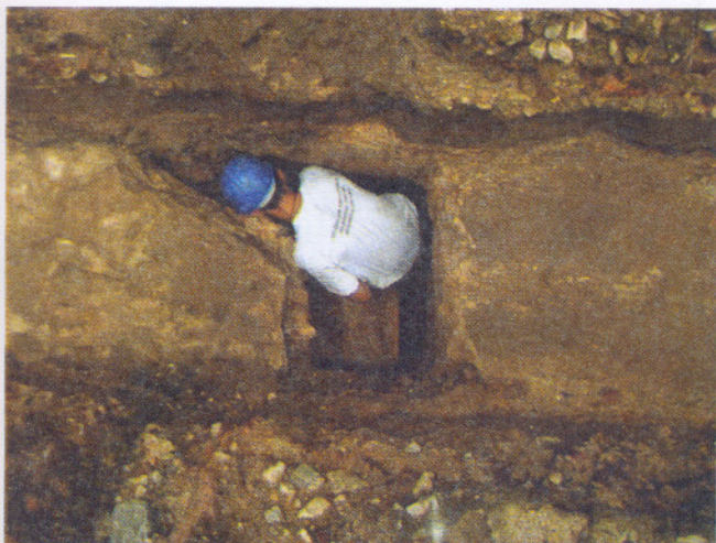
Ilustração 5 - Observe-se a proporção entre a estrutura localizada, considerando-se que a largura da vala não permitiu mostrar toda a largura do paredão.
