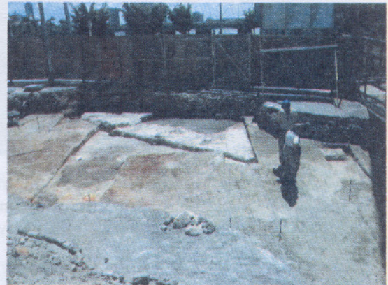
Ilustração 12 - Novos cortes buscando ampliar a área de acesso à lateral da estrutura.
