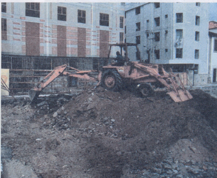
Ilustração 8 - Localizada uma estrutura, o calçamento na área de interesse foi removido com o auxílio de uma retroescavadeira.
