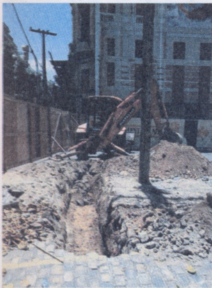
Ilustração 7 - Abertura da trincheira teste, com vistas a localizar uma estrutura relacionada ao complexo da antiga ponte.
